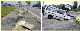
Liquefaktion: Erdbeben von Ojiva 2004 und Christchurch 2011.
